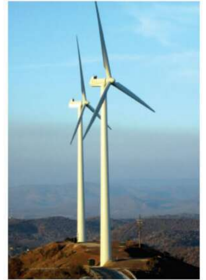
الشكل ٦ تعمل مراوح الهواء بنفس مبدأ منشآت الطاقة، وبدلاً من إدارة المحرك البخار يُدار بالمراوح التي تحركها الرياح. صف بعض مزايا وسلبيات استعمال مراوح الهواء.
