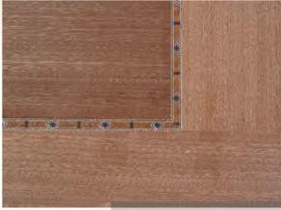
الشكل (١٦٠): تستخدم القشرة لتغطية الأسطح الخشبية على مساحات كبيرة .
