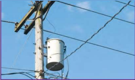
هناك أدوات تُسمى المحولات تستعمل المغناطيسية لخفض التيار الكهربائي إلى قدر مناسب ليستخدم في المنازل.
