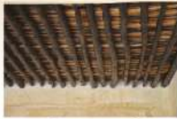
الشكل (٦) : سقف من الخشب .
