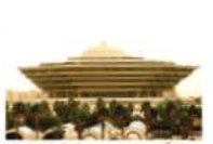
الشكل (١١): مبنى وزارة الداخلية.
