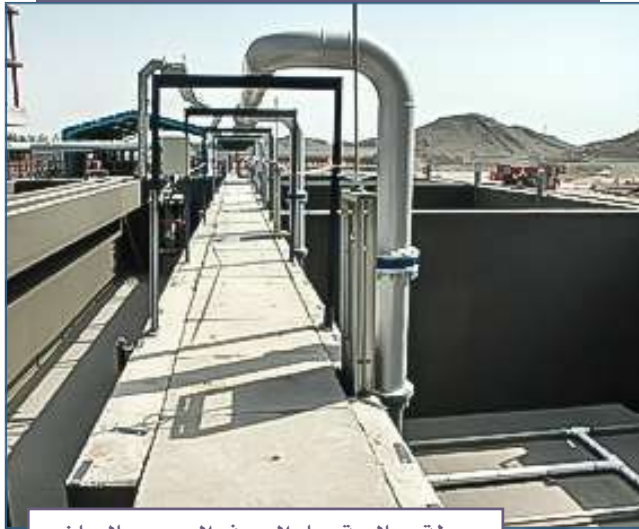
محطة معالجة مياه الصرف الصحي بالرياض
