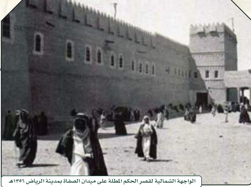
الواجهة الشمالية لقصر الحكم المطل على ميدان الصفاة بمدينة الرياض ١٣٥٦هـ
