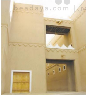
الشكل (٢) البيوت الشعبية في منطقة المربع بالرياض
