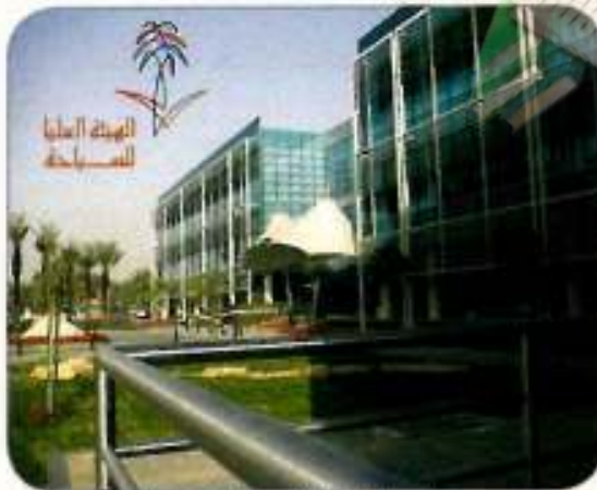
مبنى الهيئة العليا للسياحة في الرياض
