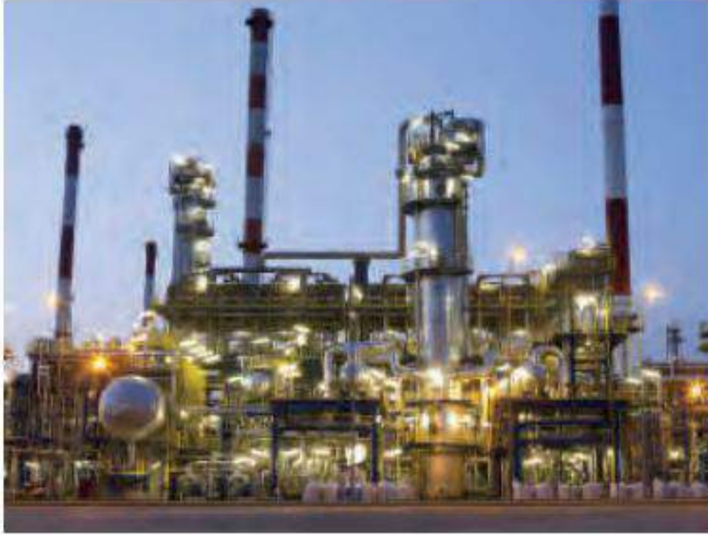
محطة توليد الكهرباء في الجبيل
